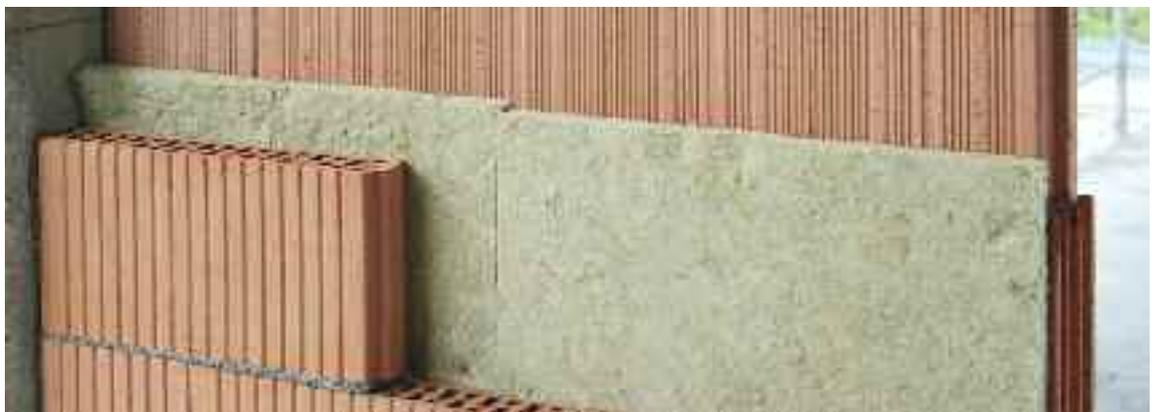
Rispetto ad analoghe pareti leggere, le tramezze **POROTON® P800** e **POROTON® PLAN™ P800** permettono di realizzare tamponamenti di facciata con massa superficiale tale da migliorare sensibilmente la prestazione termica durante
